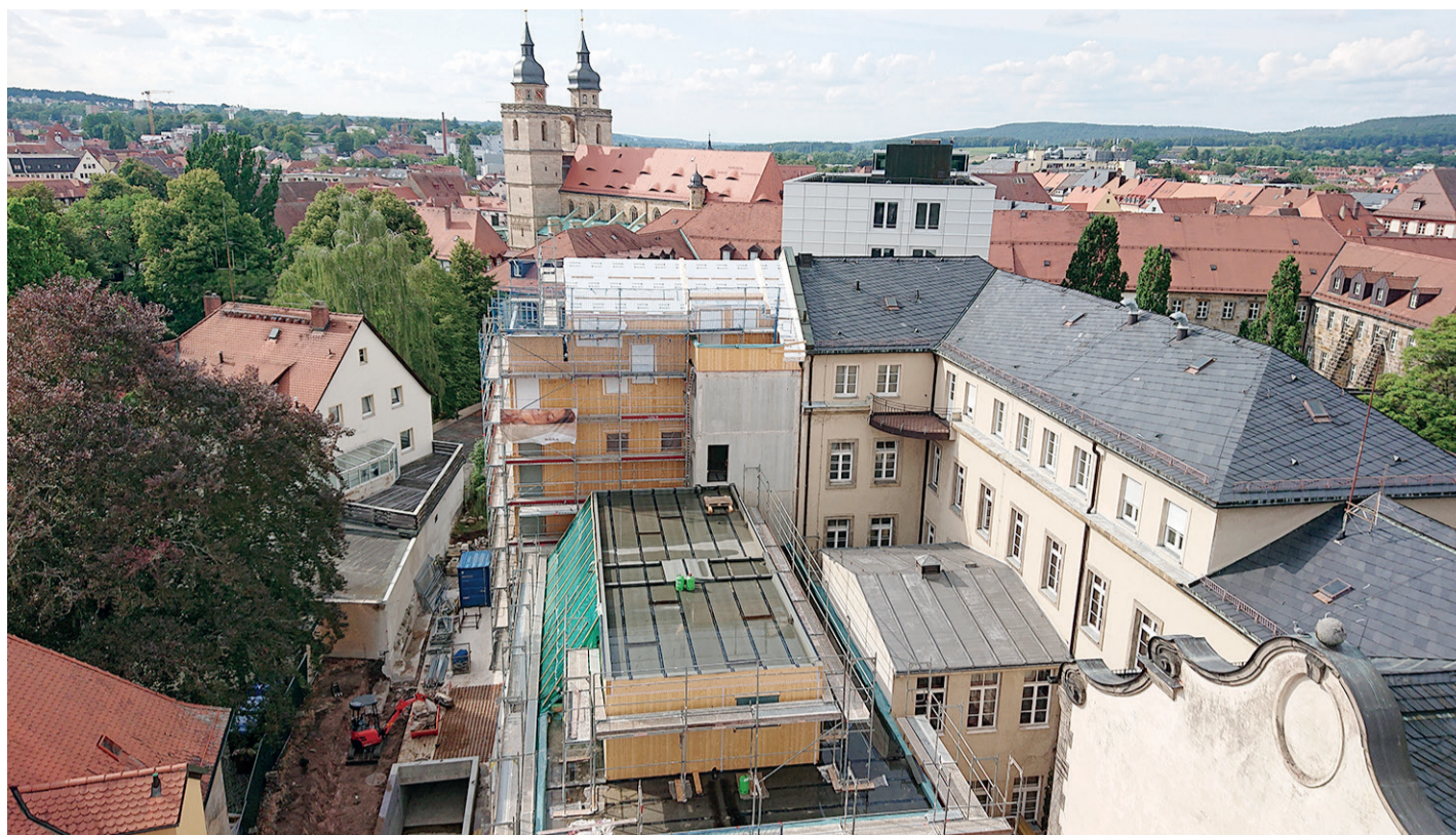
Im Herzen der Stadt entsteht an der Ludwigstraße derzeit Bayerns erster fünfgeschossiger Wohnbau aus leimfreiem Massivholz. Alle Vorteile des Baustoffes Holz werden hier genutzt.
