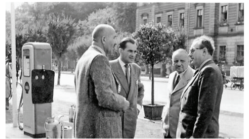
Baubesprechung von Fritz Holl (links) und Karl Dörnhöfer.
